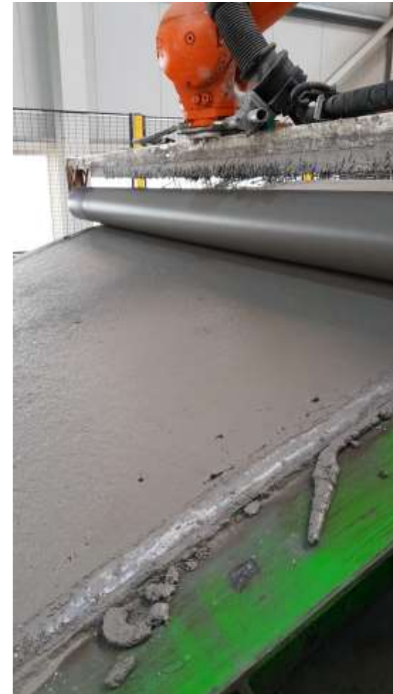
BRENNER BASE TUNNEL H41 (Implenia- Webuild)
